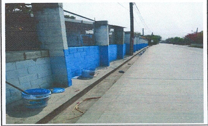
Foto 2: Pintura de muros interiores y exteriores.
